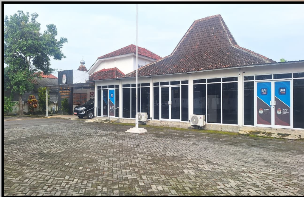
Gambar 4 dan Gambar 5. Gedung Kantor dan Gudang KPU Kabupaten Bantul
