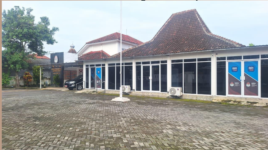
Gambar 12 Gedung KPU Kabupaten Bantul
